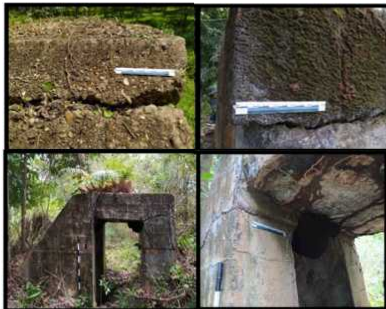
Gambar 4. Pelapukan Biologis dengan adanya Lumut, Rayap dan Tumbuhan Lain (Sumber: Dok. Andi Hardianti, 2020)
